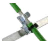
Reprise de blindage sur barre collectrice
