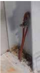
Terre de fond de fouille
